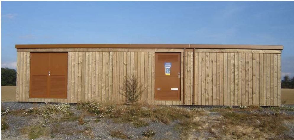
Photographie 1 : Aspect extérieur du poste de livraison
